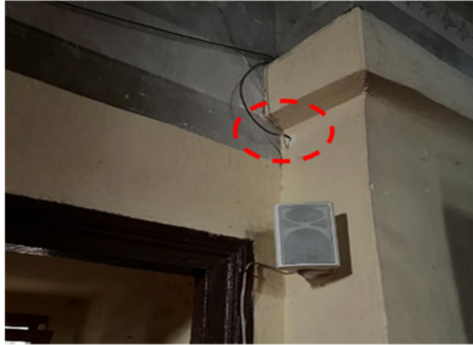
Şekil 10. Dikey eksene monte edilmiş elektrot (kırmızı daire içinde gösterilmiştir).
