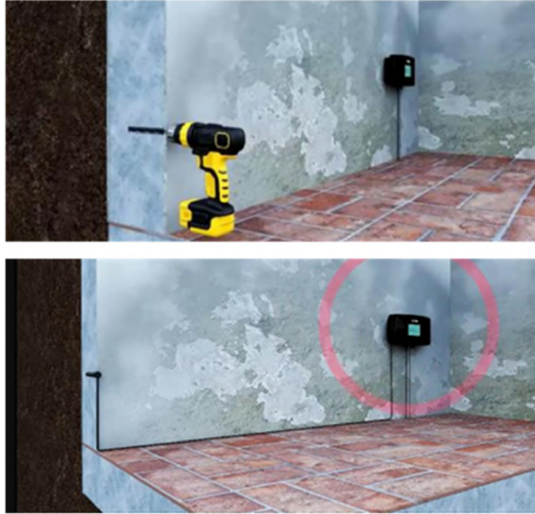
Şekil 3. Kılcal nem arıtma cihazının kurulumunun ilk aşaması [41].
